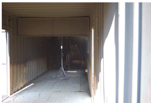
Obrázek 11: Zástěna v horní části výcvikového prostoru
