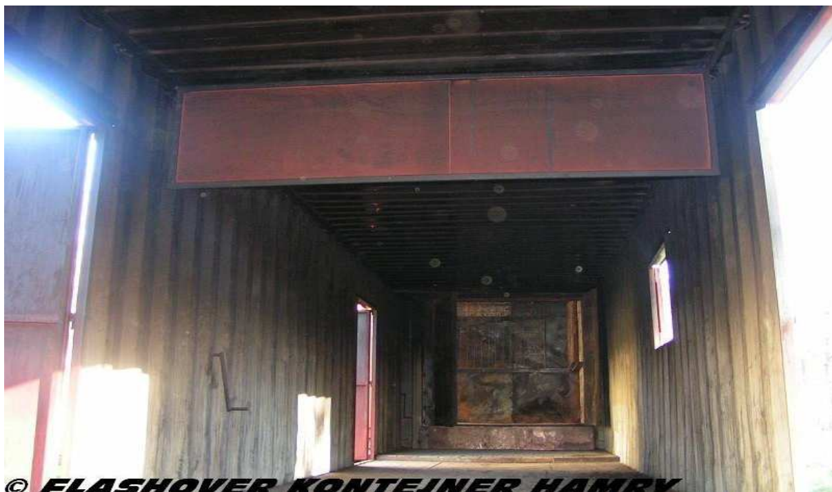
Obrázek 3: Pohled do výcvikové části, u stropu je vidět instalovaná zástěna. [25]
