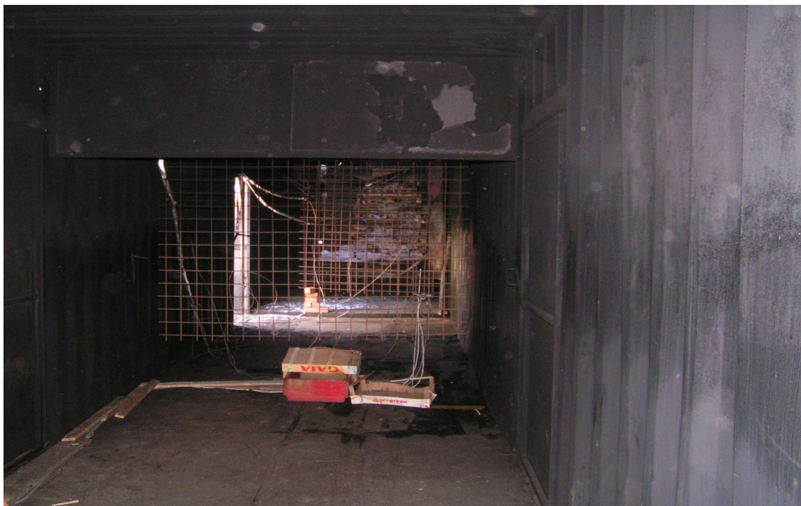
Obrázek21: Umístění druhé sítě a rozmístění termočlánků Rozmístění termočlánků na druhé síti (pohled z topeniště):
