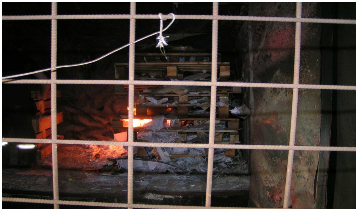
Obrázek 22: Pohled na naloženou rozhořívající pec
